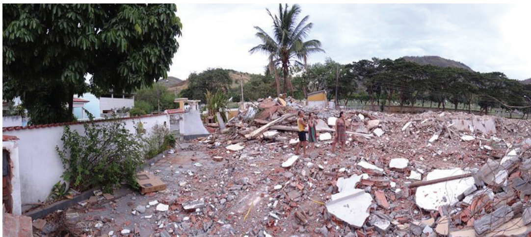
FIGURA 2 - Remoção de casas para implantação de viaduto. Projeto TransOlimpica, Jardim Sulacap,
