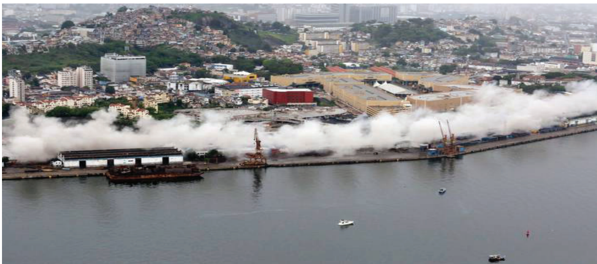
FIGURA 1 - Implosão do viaduto da Perimetral, Centro do Rio de Janeiro
